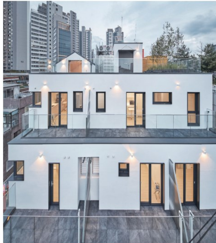
다승 유리난간 두겹후래싱 시공
